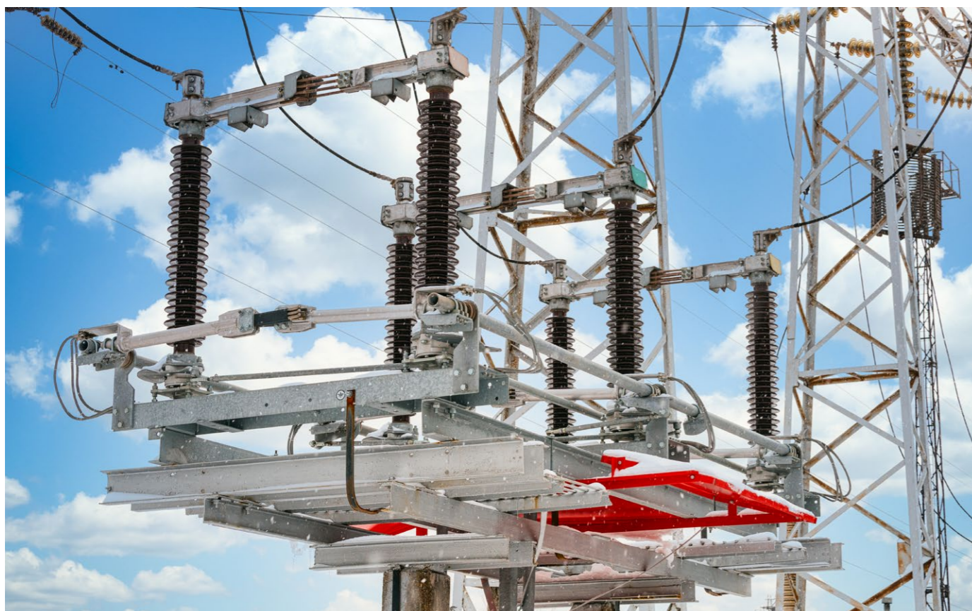
Реконструкция разъединителя на ПС 110 кВ Мотор для заказчика ЕМУП МЭС, г. Екатеринбург
